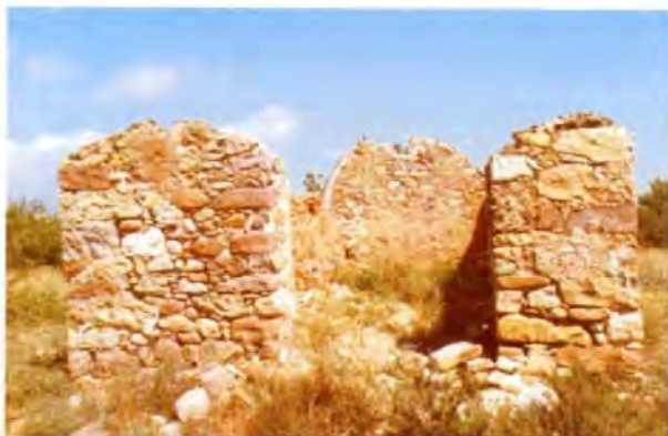
Estado ruinoso de la caseta de volta de Carmaday, situada entre dicha colonia y el río Belcaire.
