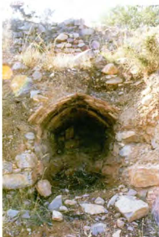
Boca del foc del horno de la Punta, construida en bóveda rampante por la que se alimentaba el fuego necesario para la cocción de la cal.
