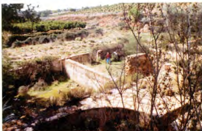
En estas grandes balsas que constituían el segundo nivel quedaba sedimentado el mineral de hierro, siendo finalmente arrastrado por el agua hacia el barranco todo el resto del material estéril.
